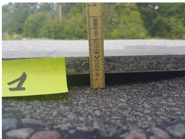
Bild 3. Mätning av lagningens nedsjunkning med tumstock.
