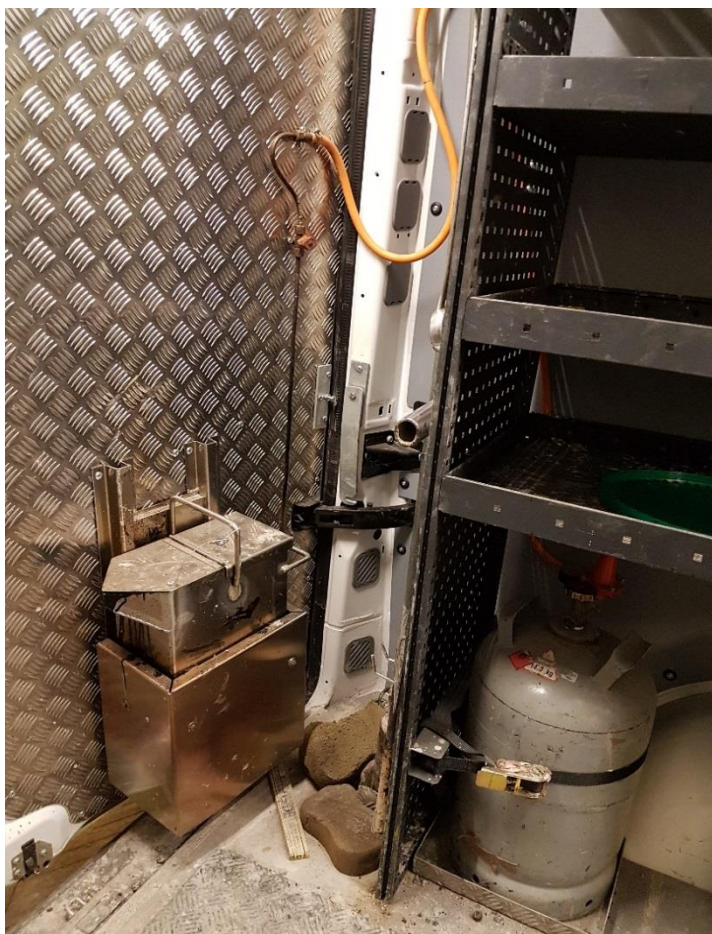
Bild 2. Gasolinstallation till grytan som används för att värma upp oxiderat bitumen för lagning av borrhål.
